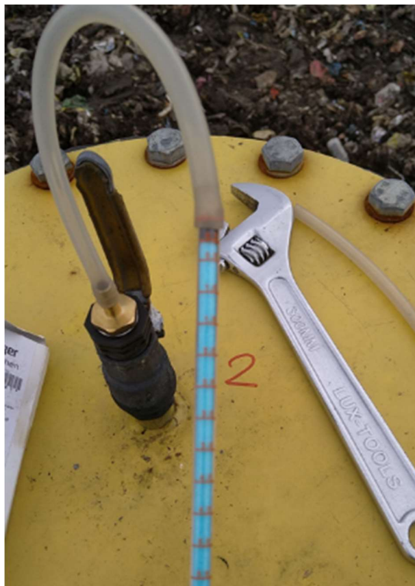
Fot. 10 Pomiar stężenia siarkowodoru przy pomocy rurki Draegera
