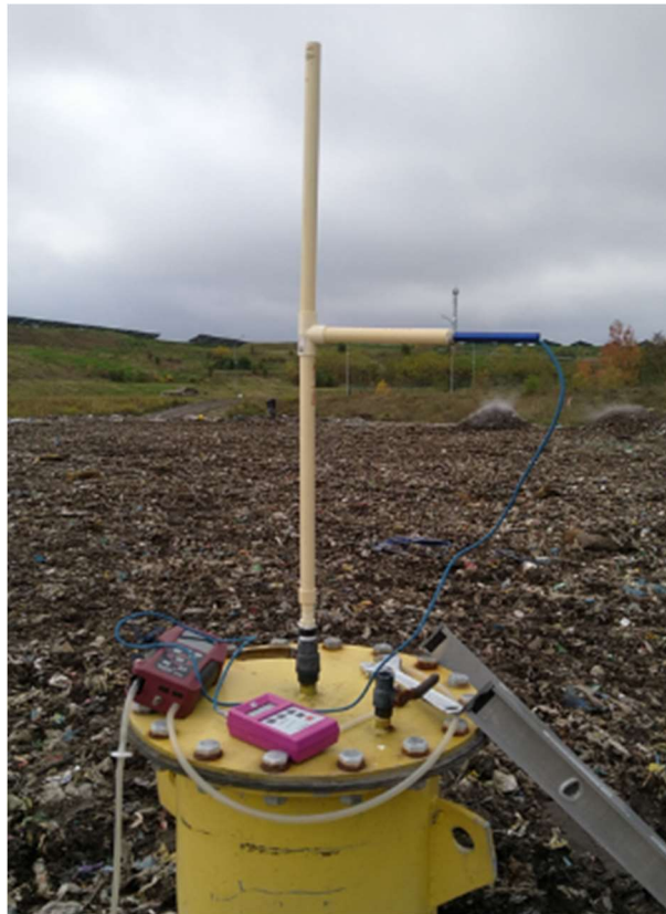
Fot. 3 Pomiary parametrów gazu w studni
