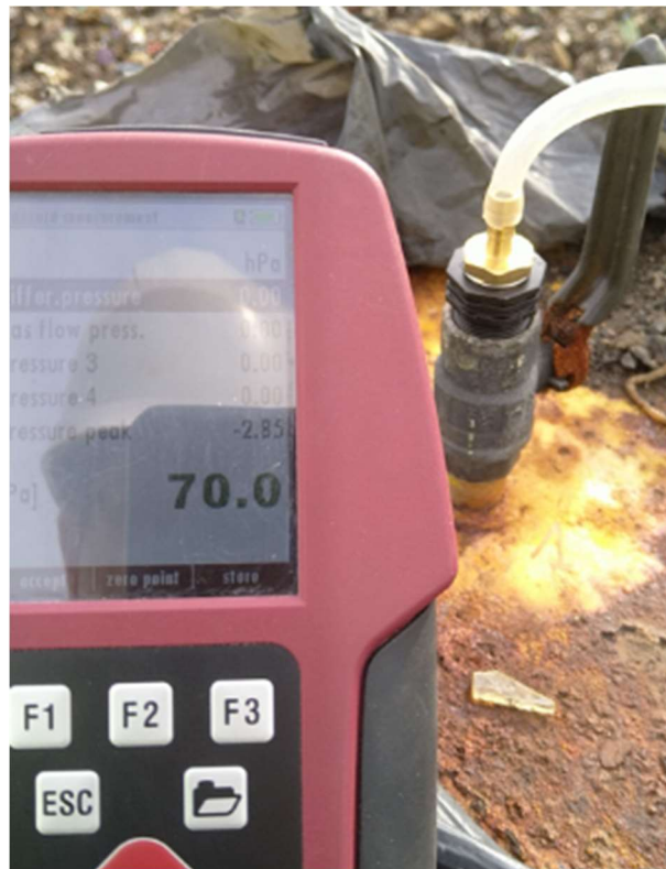
Fot. 7 Pomiar ciśnienia gazu w studni gazowej
